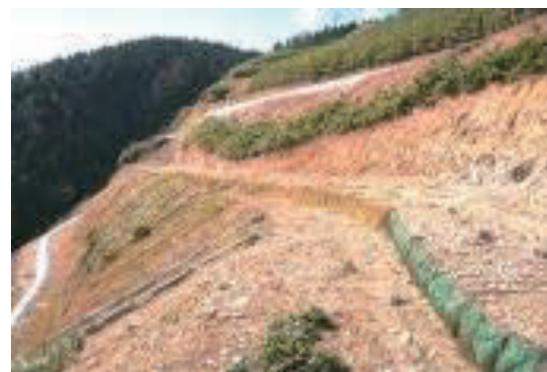
図4 工事直後の状況
